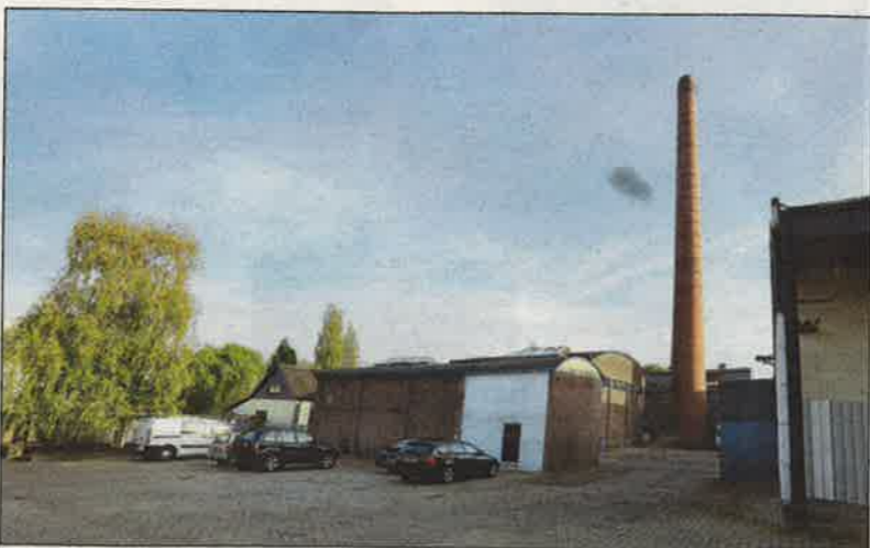
■ Het voormalige ketelhuis van de Nettenfabriek, met de tientallen meters hoge schoorsteen als baken in het stationsgebied.
